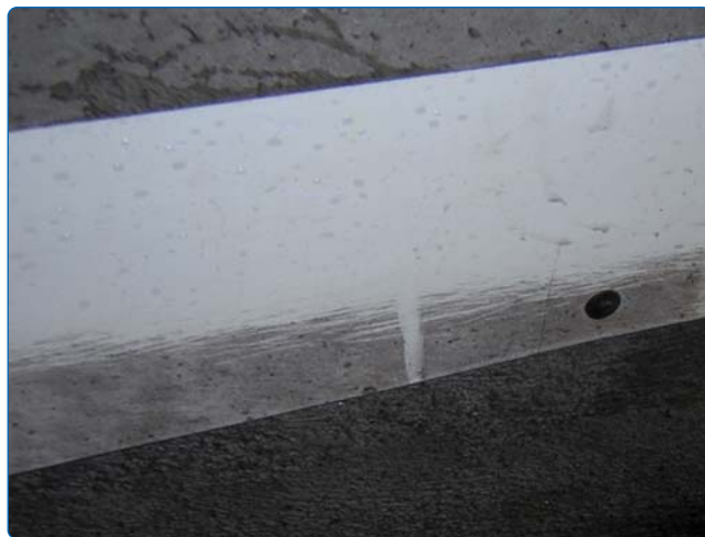
Fig. 8 - Particolare della segnaletica all'interno della galleria nel quale si può apprezzare la differenza di visibilità prima e dopo l'intervento. L'immagine è stata scattata in seguito al passaggio della spazzola superiore e prima dell'arrivo di quella inferiore
