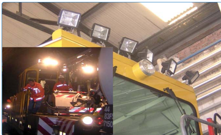
Fig. 5 - Particolare dell'impianto alogeno di illuminazione del "SALT400"
