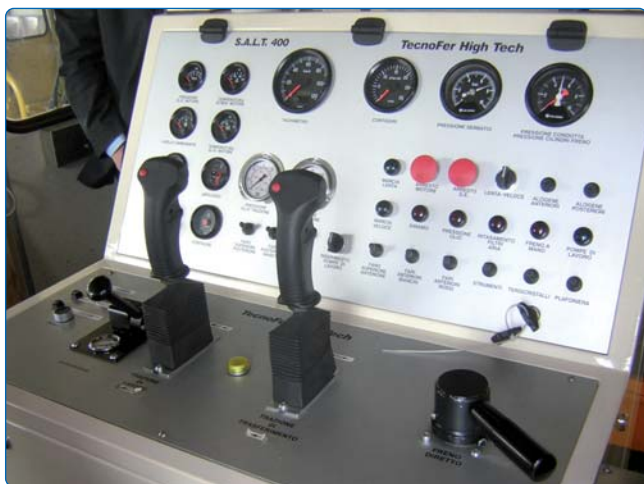
Fig. 4 - Banco di manovra del treno "SALT400"
