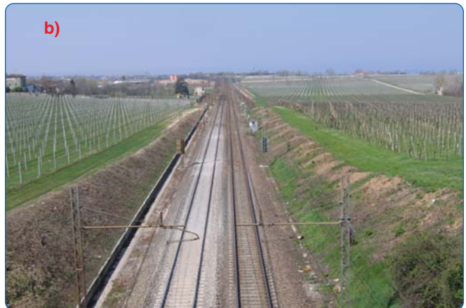
Fig. 16 - Tratta di linea in trincea (Peschiera del Garda) a) prima dei lavori; b) dopo intervento di taglio piante
