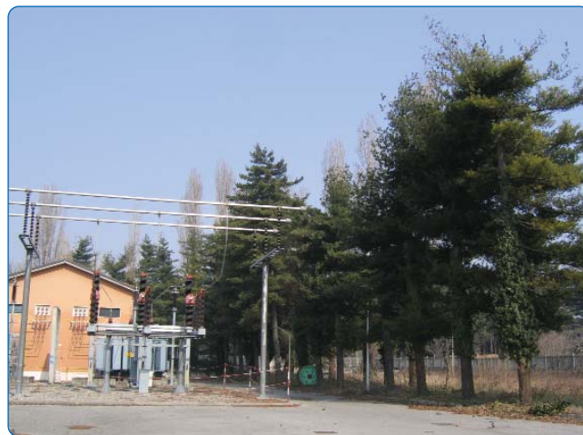
Fig. 20 - Esempio di piante ornamentali con funzione di barriera antirumore in una SSE
