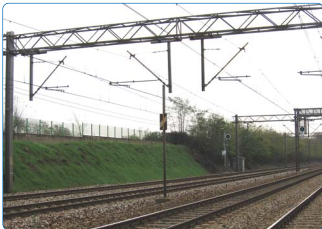
Fig. 13 - Intervento parziale di idrosemina
