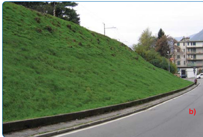
Fig. 18 - Scarpata di una linea ferroviaria in ambito cittadino (salita dei Cappuccini - Como) a) prima dei lavori; b) dopo idrosemina e diserbo selettivo
